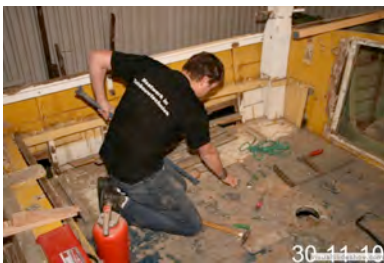
Peter van Dijk demonteert de afsluiters van de loospipen.
