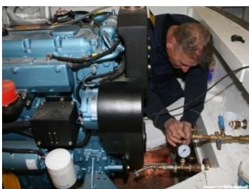
Aansluiting op de warmtewisselaar.
