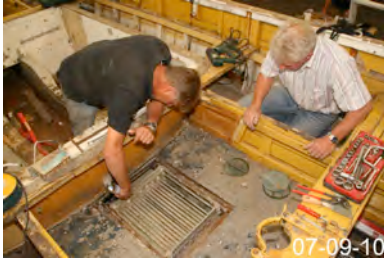
De warmtewisselaar ingebouwd in een bun onder het dek in de voorkuip
